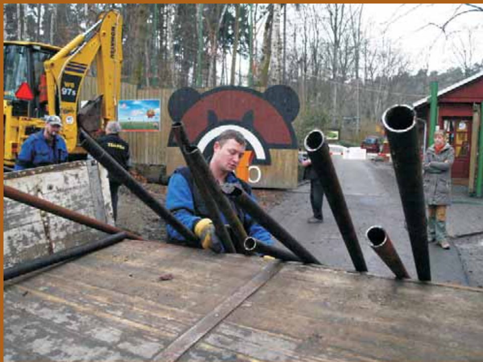
Stavba nového plotu začala demontáží toho starého. / Der Bau des neuen Zaunes begann mit der Demontage des alten. / Building the new fence begun with dismantling the old one.
